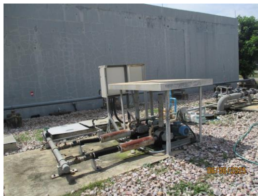
ภาพที่ 2-10 บ่อบำบัดสำเร็จรูป (Septic tank) ชนิดเติมอากาศ
