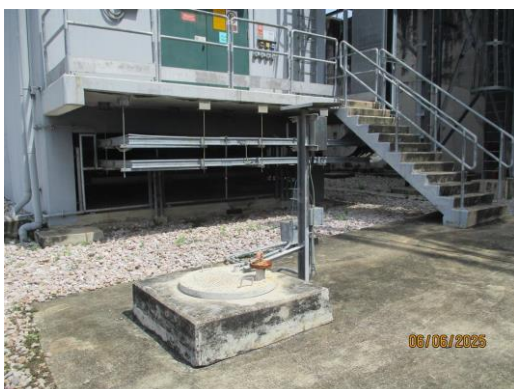
ภาพที่ 2-10 บ่อบำบัดสำเร็จรูป (Septic tank) ชนิดเติมอากาศ
