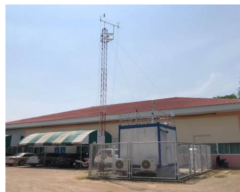
ภาพที่ 2-3 ระบบติดตามตรวจสอบการระบายมลพิษอย่างต่อเนื่อง (CEMs)
