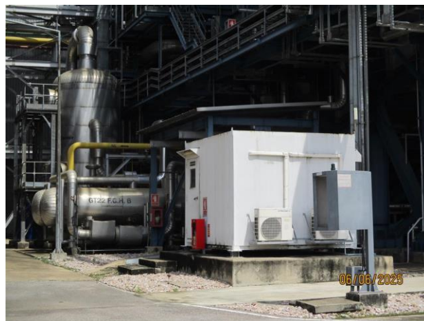
ภาพที่ 2-3 ระบบติดตามตรวจสอบการระบายมลพิษอย่างต่อเนื่อง (CEMs)
