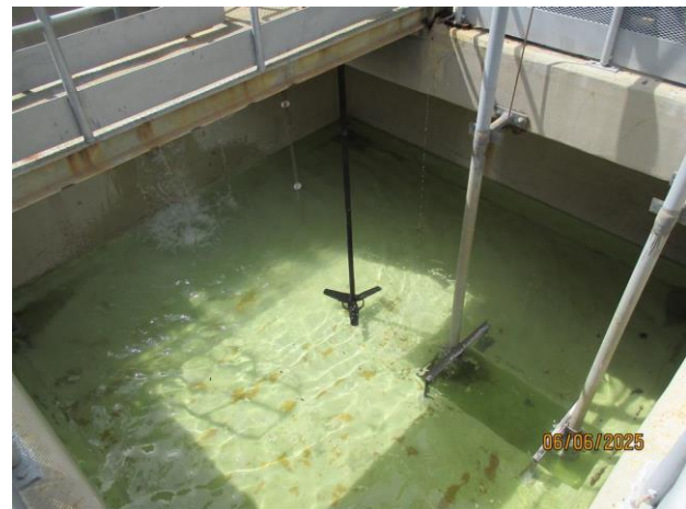
ภาพที่ 2-12 บ่อสะเทินสำหรับปรับสภาพน้ำทิ้งปนเปื้อนสารเคมีให้เป็นกลาง
